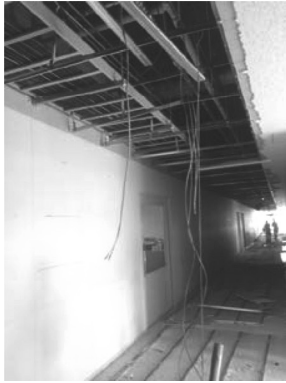
2号館4階の天井張替
