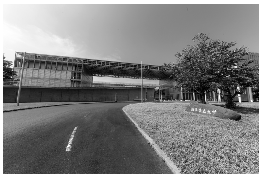
写真1 埼玉県立大学 外観
