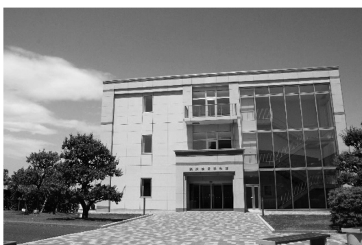
写真1 臨床検査学科棟(2014年3月完成)
